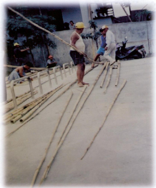
圖 20 將粗的刺球竿頂住牆壁 使兩枝竹竿緊密接合
